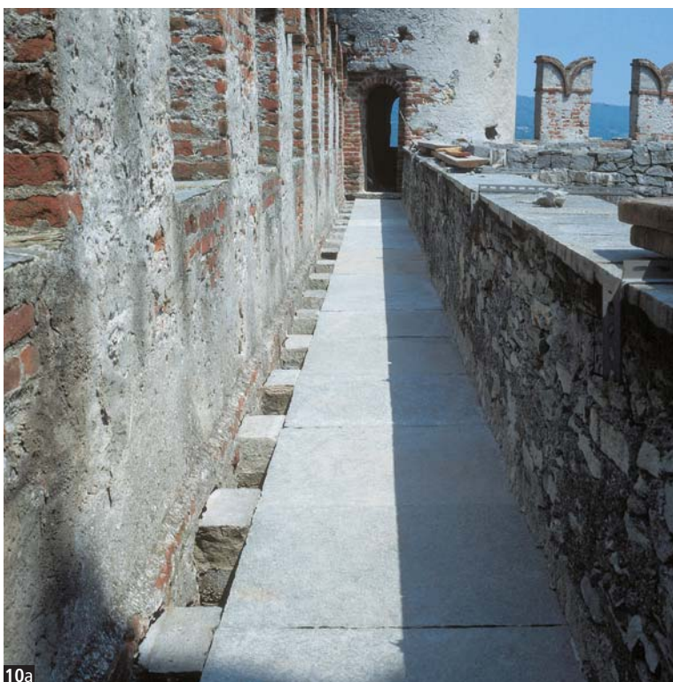
Figure 10a-b Particolari del camminamento dopo l'intervento di ripristino della pavimentazione. Figura 11 Particolare di un doccione in pietra di nuovo inserimento realizzato utilizzando come modello un doccione ancora presente in opera in corrispondenza del fronte nord del complesso.
