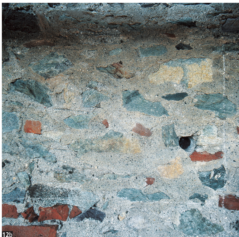
Figura 12 Particolari del paramento murario del fronte sud prima degli interventi di pulitura e stilatura dei giunti (a) e a intervento ultimato (b).
